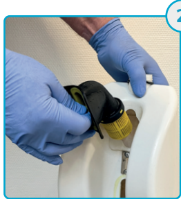
Tag flydespærren ud og rens den Remove the float cage and clean it
